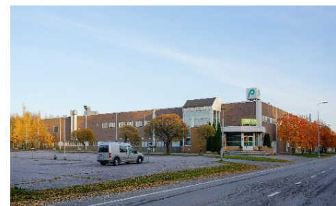
Teollisuuskiinteistö alueen kaakkoispuolella
